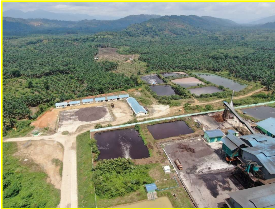
Gambar 2. 12 Pabrik Kelapa Sawit di Nagari Aie Amo
